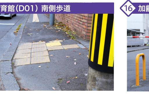
歩道が狭く、横に傾いているほか、破損した点字ブロックもあるため、転倒に注意が必要である。
