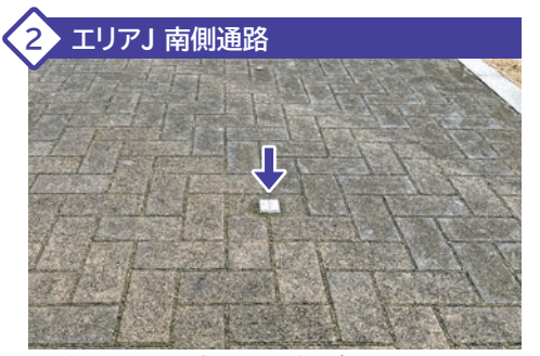
2 エリアJ 南側通路 通路に2cm程度の突起物があるため通行時は、注意してください。
