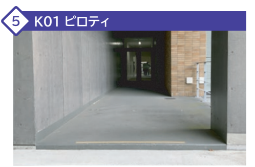
5 K01 ピロティ 出入り口前に10cmの段差があります。北棟側から通過する場合、段差に気付かずいため転落に注意してください。
