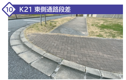
10 K21 東側通路段差 通路の接続部分に段差があるため転倒に注意してください。
