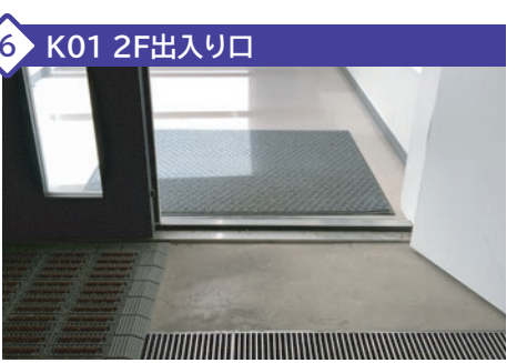
6 K01 2F出入り口 北棟西側エレベーターを降りると、屋外に出ます。屋内に入る場合の扉は引き戸で5cmの段差があるため、通行時は注意して下さい。
