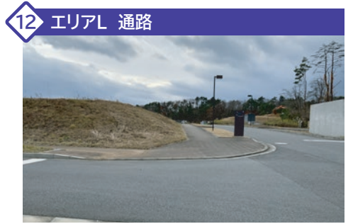
12 エリアル 通路 通路が大きく片傾斜になっているため、通行時は注意してください。
