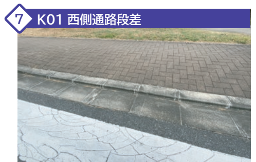
7 K01 西側通路段差 横断歩道の接続部分が急傾斜かつ3cmほどの段差があるため、転倒に注意してください。
