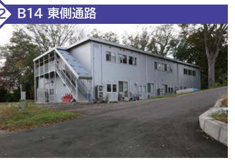
通路の傾斜が急で、建物へ向かう場合は横の傾きとなるため、転倒に注意してください。
